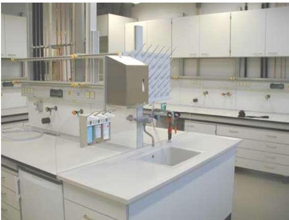
Mittelständiger Labortisch mit Energiezelle, Reagenzienablagen, Medienversorgung von oben
