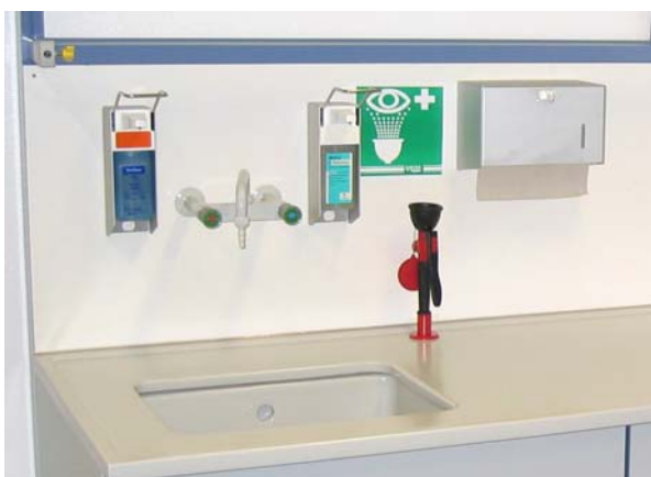
Spüle mit Hygiene- und Sicherheitszubehör: Seifen-, Desinfektionsmittel-, Handtuchspender; Augendusche tischbefestigt
