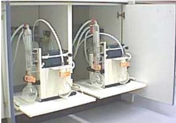
Vakuumpumpen installiert auf Rollauszügen im Unterbau
