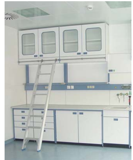
Wandenergiezellen mit Hängeschränken, Leiterschienenzarge und Anstellleiter
